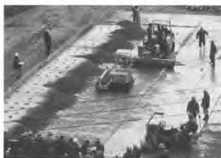
写真-5 各施工装置実証実験(1)
