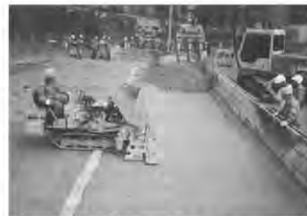
写真-3 モルタル敷き均し装置
