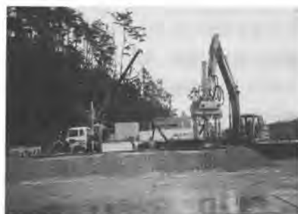
写真-6 各施工装置実証実験(2)
