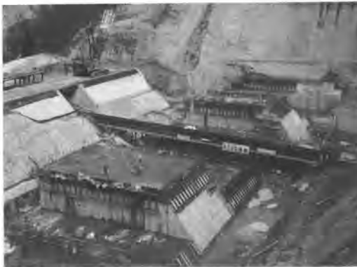
写真-3 現場全景
