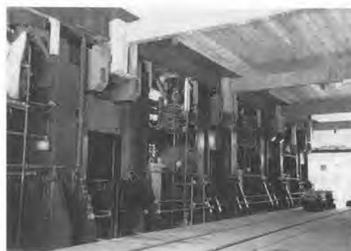
写真2 建物押し上げ状況
