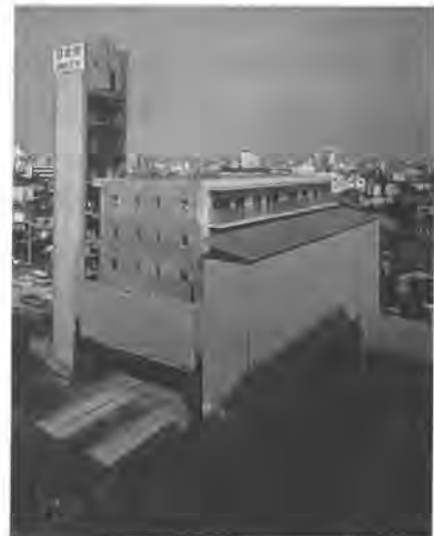
写真-1 施工状況
