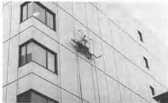
写真3 壁面検査状況
