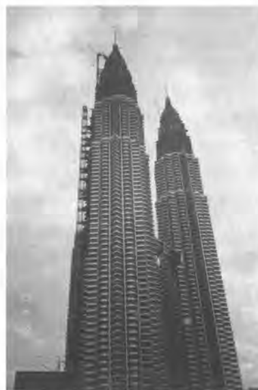
写真-2 96年6月全景
