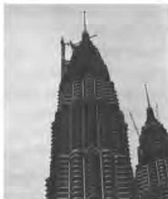
写真-3 解体用クレーンの設置
