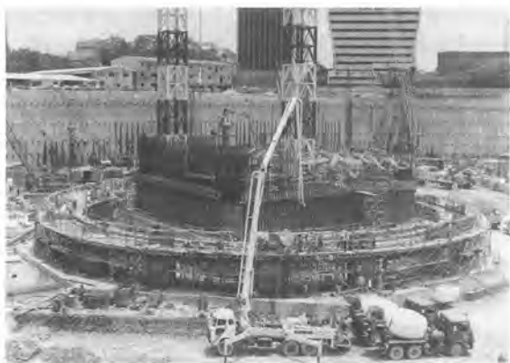
写真-1 94年3月全景
