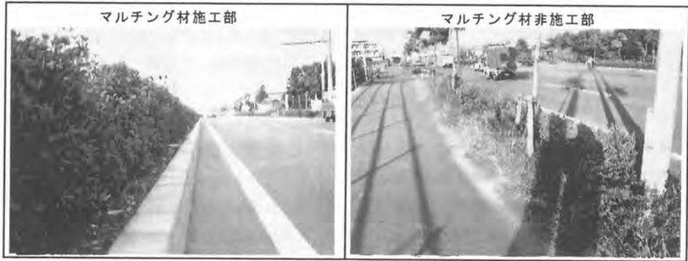
写真-9 平成7年10月 9日(9ヶ月後)
