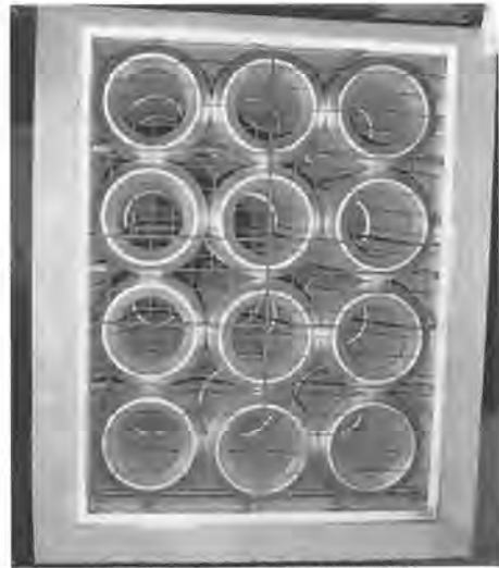
写真-2 主ファンの消音装置
