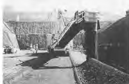
写真-1 掘削試験状況
