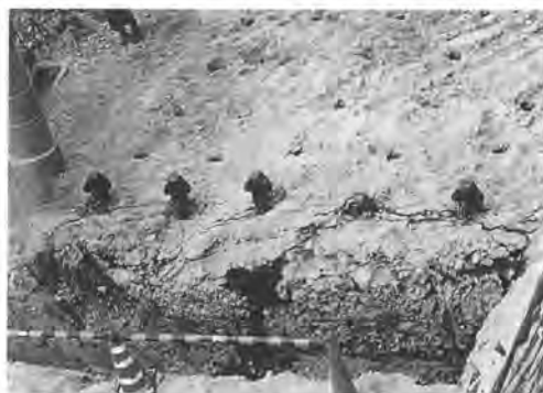
写真-3 割岩試験状況
