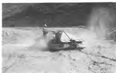
写真-3 巨大ドライヤー施工状況
