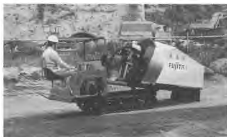
写真-4 造成現場での施工状況
