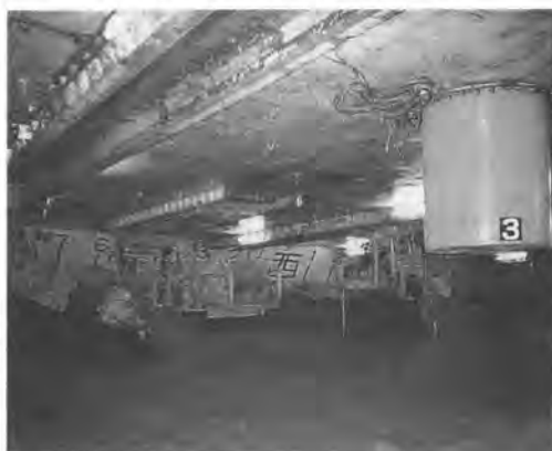
写真-2 無人掘削状況
