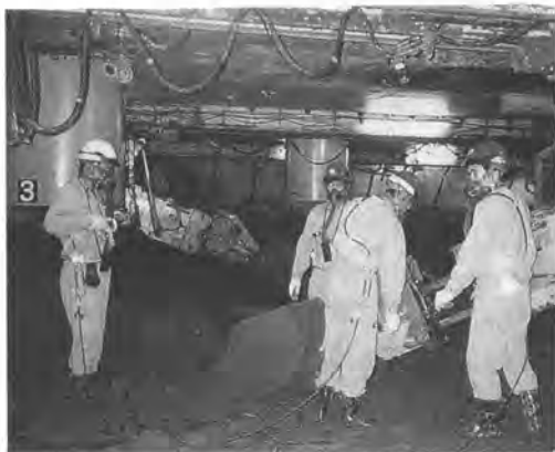
写真-5 掘削機械メンテナンス状況
