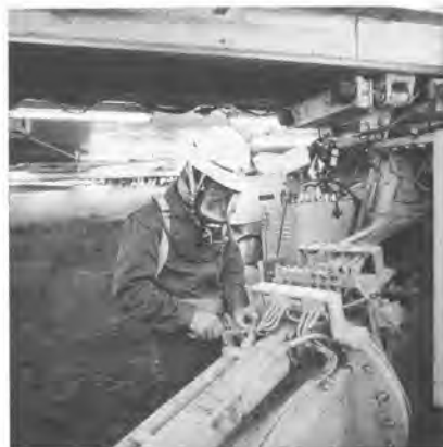
写真-5 トライミックスマスクを装着しての作業状況
