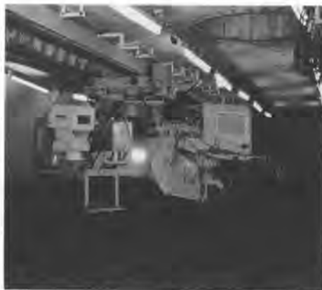
写真-1 稼働中の掘削機
