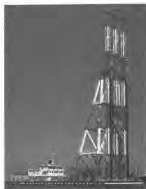
写真-1 地盤改良船
