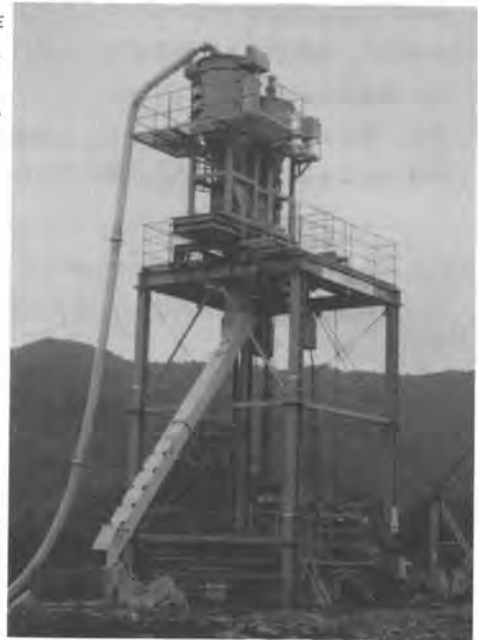
写真－4 施工状況
