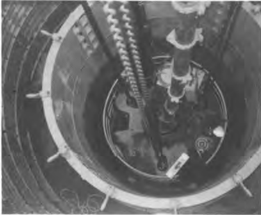
写真－2 掘削状況
