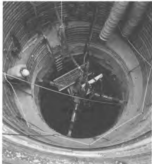
写真-4 吹付状況
