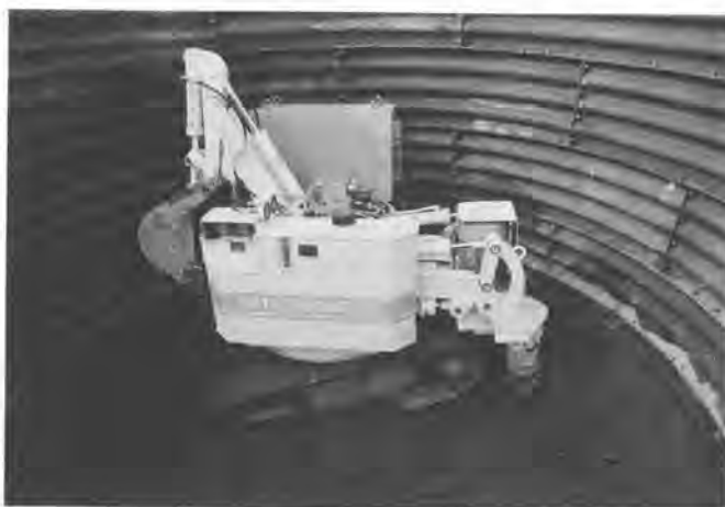
写真-1 深礎工事ロボット
