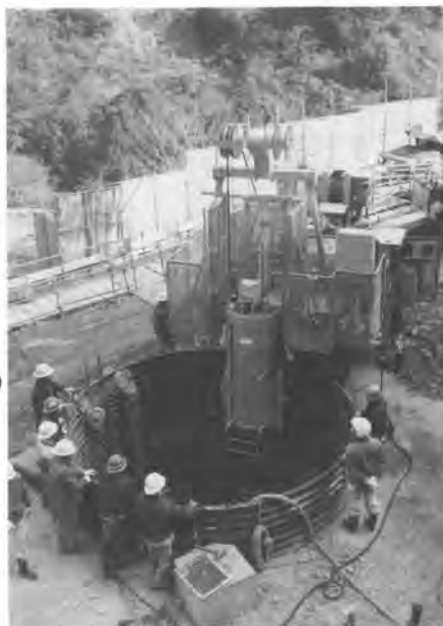
現場使用状況
