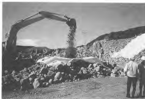
写真3 陸上載荷試験（落下高3.5m）
