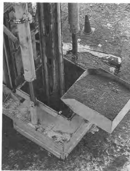
写真-2.2 載荷板兼用固定式土砂ホッパー
