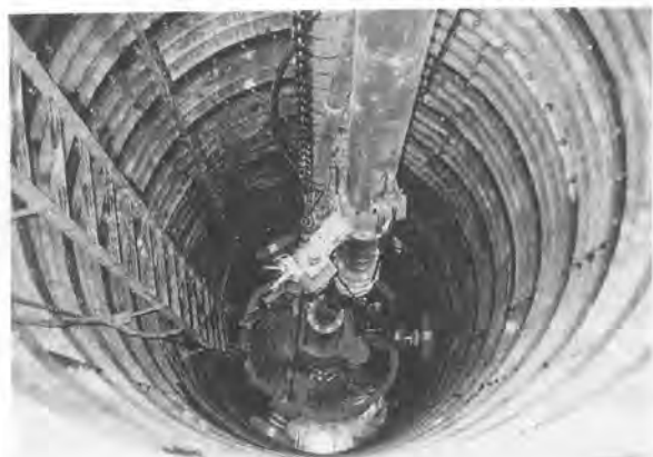
写真-3 立坑内の機械設置状況
