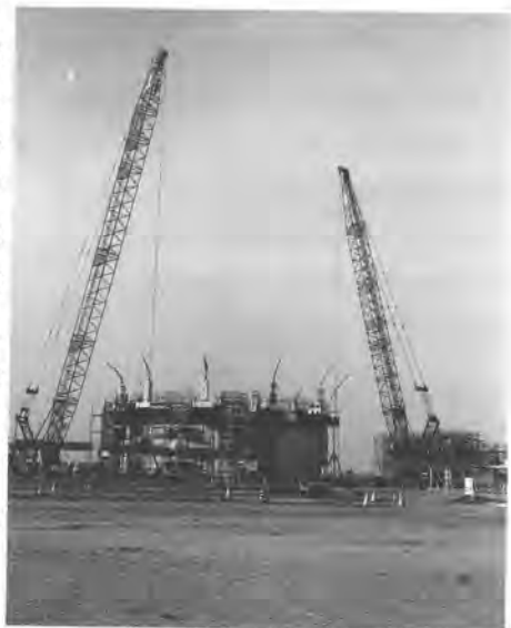
写真-1 施工状況
