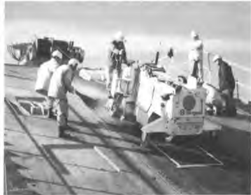
写真-1 切削状況
