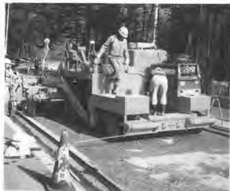
写真1 ワレール式薄層フィニッシャ
