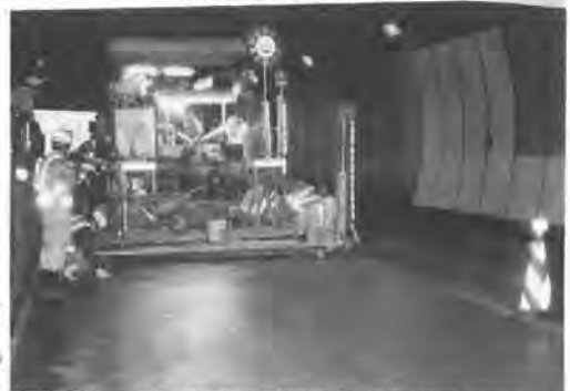
写真2. 薄層コンクリートの施工
