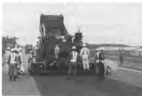
写真-1. 施工状況
