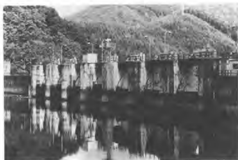
写真-1 ダム上流側全景
