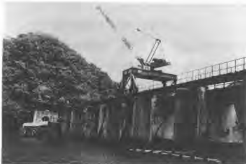
写真-3 揚重設備
