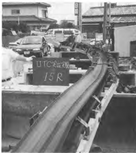
写真2 15 R 実証実験状況
