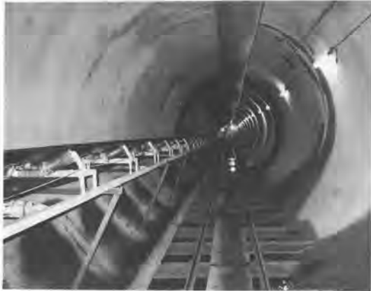
写真-1 坑内ベルトコン設置状況
