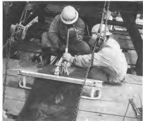
写真-4 機械的ベルト接続作業
