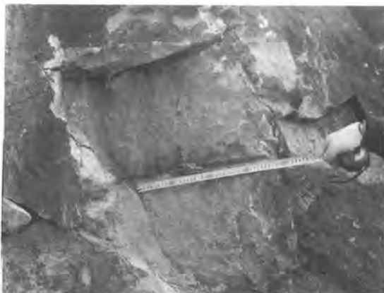
図11 岩盤の心抜き破碎例
