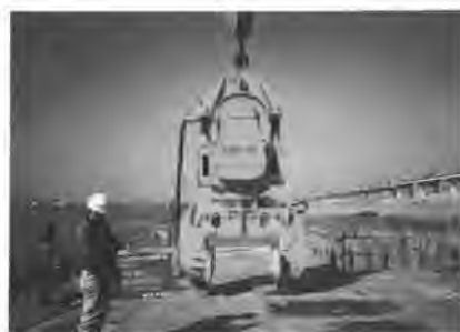
写真-1 専用パイプロハンマ
