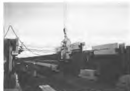
写真-2 施工状況
