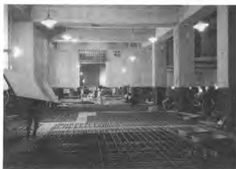
写真－2 逆打工法躯体工事
