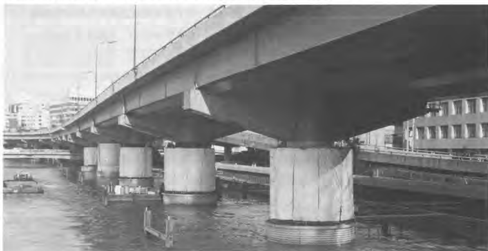
写真-1 現場全景
