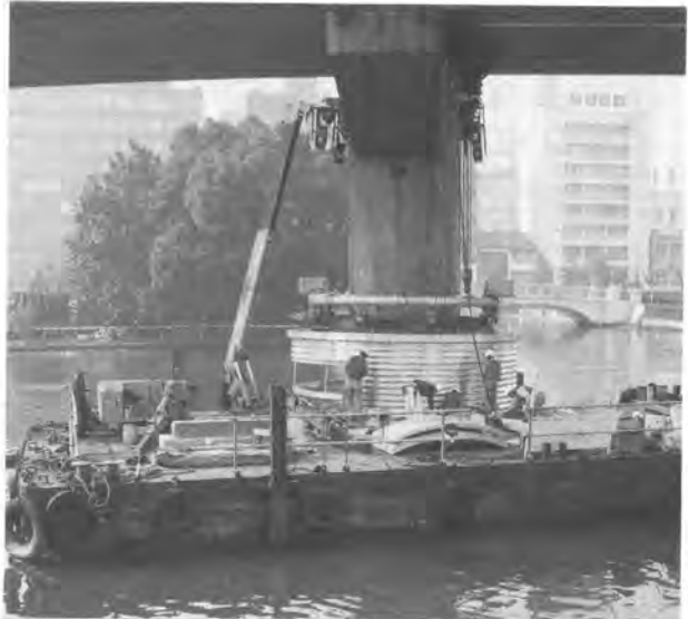
写真-3 CP組立状況
