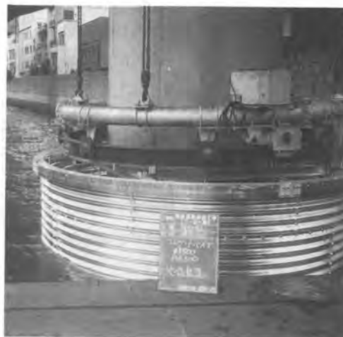
写真-7 CP沈設完了状況
