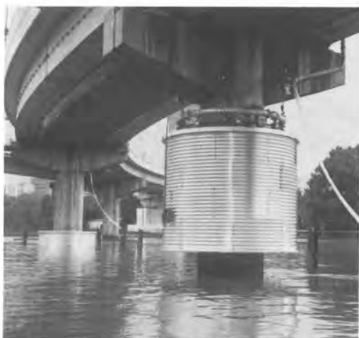
写真-6 CP組立完了状況
