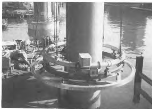
写真-5 組立装置 + トップリング
