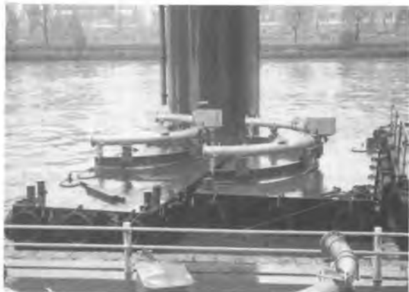
写真-4 組立装置分割状況
