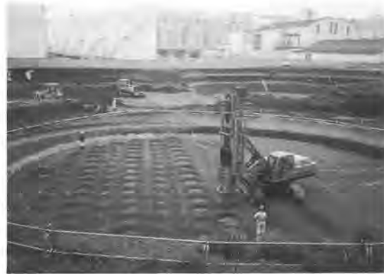
写真-2 石油タンク基礎地盤における施工状況
