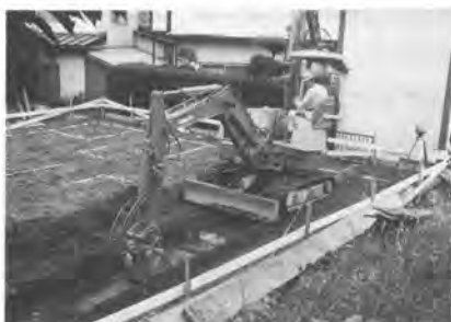
写真3-5 振動締固め
