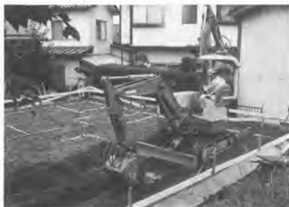
写真3-5 振動締固め
