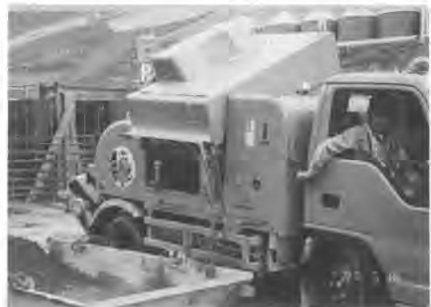
写真-5 ずり排出状況
