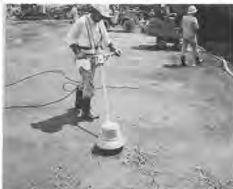
写真－1 人力によるグリーンカット作業
