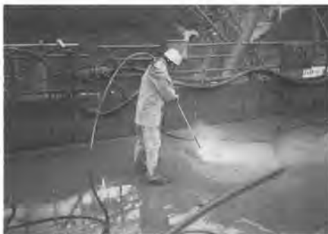
写真-6 保護具を用いての人力作業
