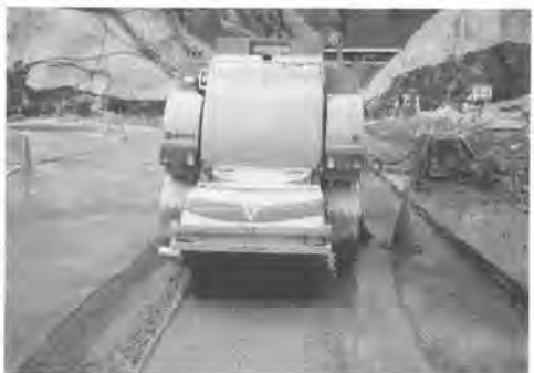
写真-7 グリーンカット作業状況 (上:人力作業, 下:本機による作業)
