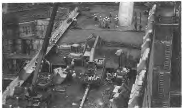
写真-2 施工状況
