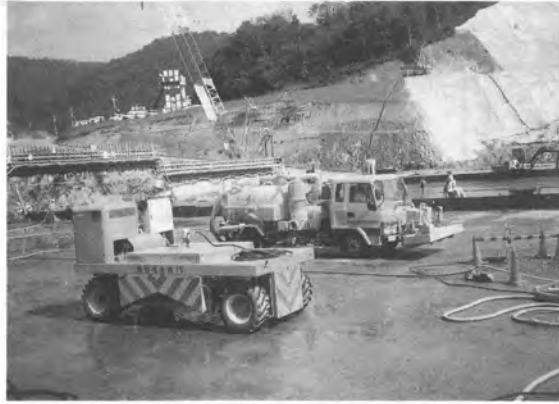
写真-1 打継目処理機械
