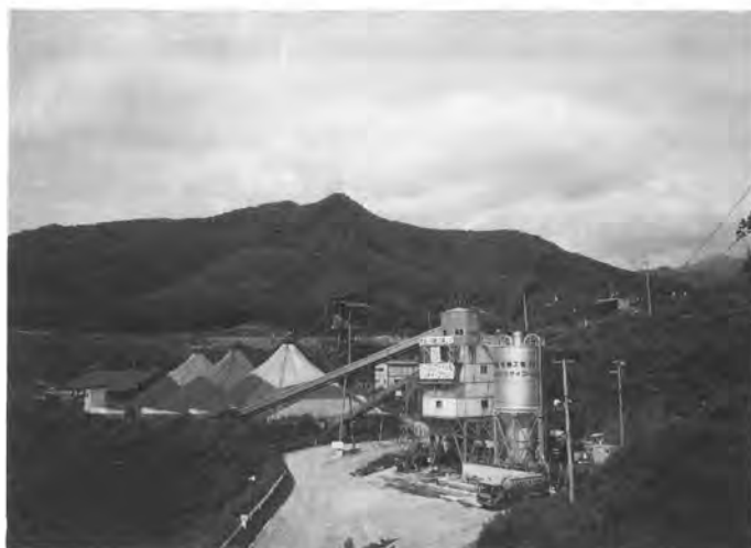
写真-1 プラント全景
