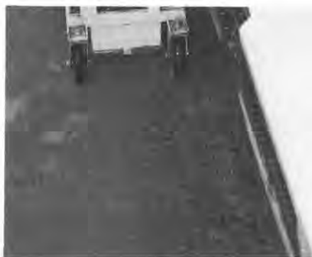
写真-2 グリーンカット状況 (直射)
