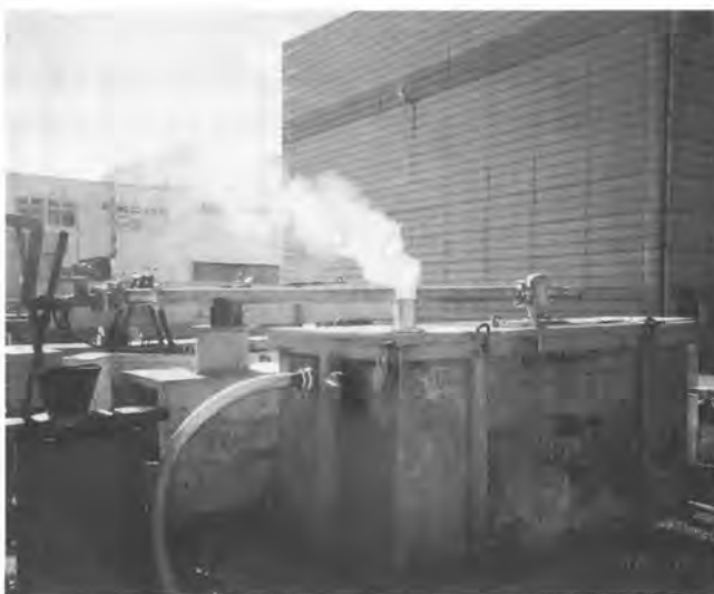
写真-2 煤煙捕捉装置と蒸気の排出状況
