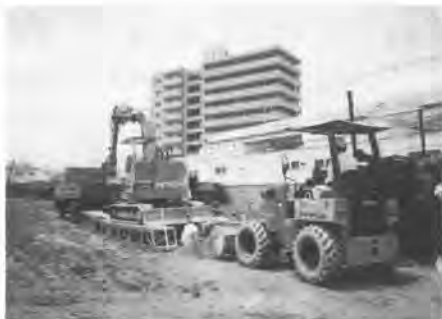
写真-3 掘進状況（架台上掘削）
