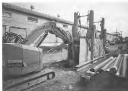
写真-2 自降状況
