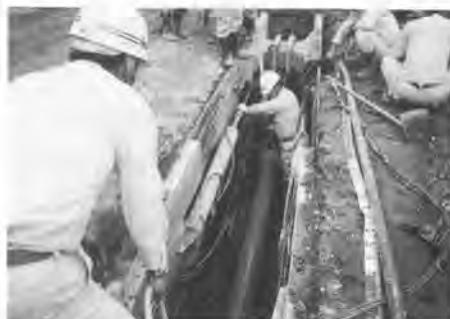
写真-4 管布設状況
