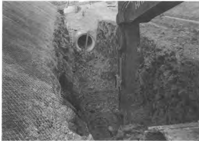
写真4 領域制限掘削機能を搭載した油圧ショベルによる管理設工事の施工状況 (b)
