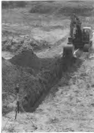
写真1 レーザ灯台を用いた外部基準の設定状況
