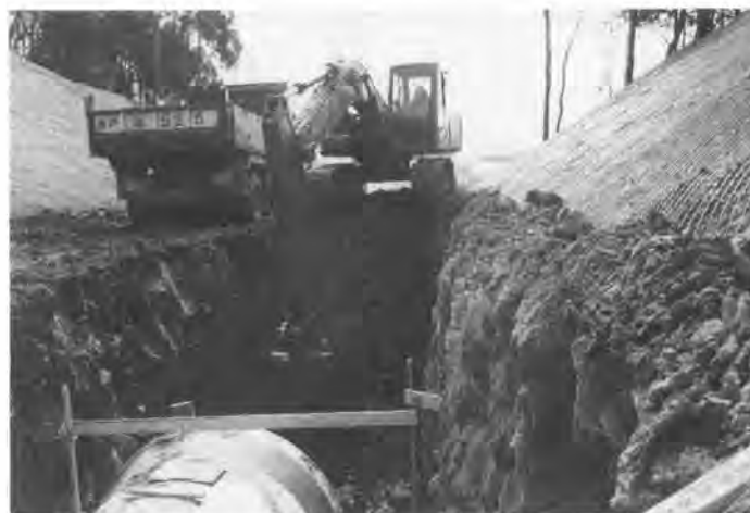
写真3 領域制限掘削機能を搭載した油圧ショベルによる管理設工事の施工状況 (a)
