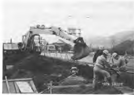
写真-4 現場適応性調査状況
