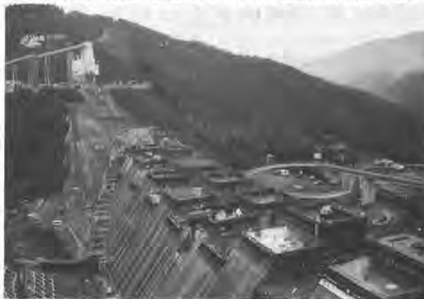
写真-1 鳴淵ダム建設工事全景
