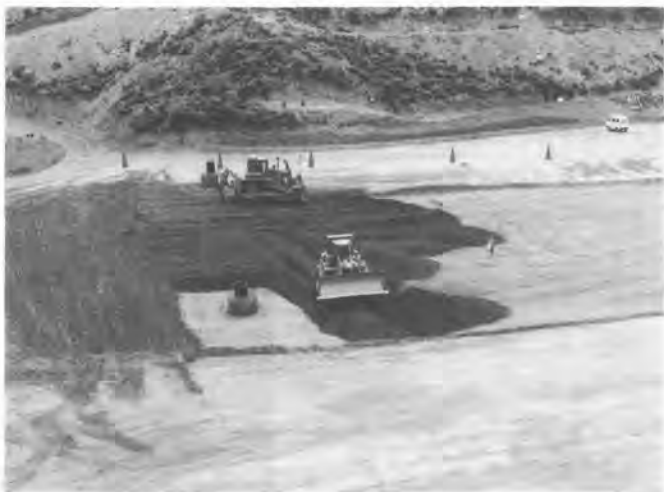
写真-7 阿南変換所敷地造成工事
