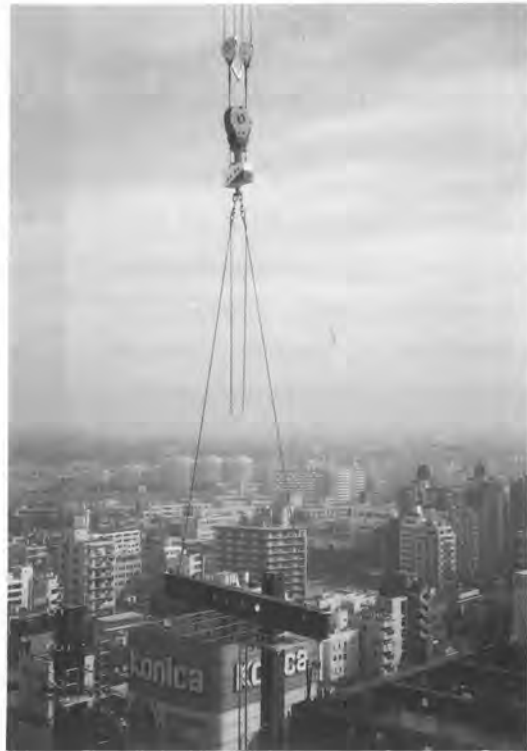
写真1 吊荷回転誘導装置の全景
