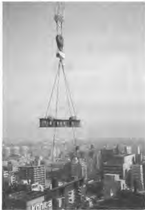
写真2 鉄骨梁取り付け
