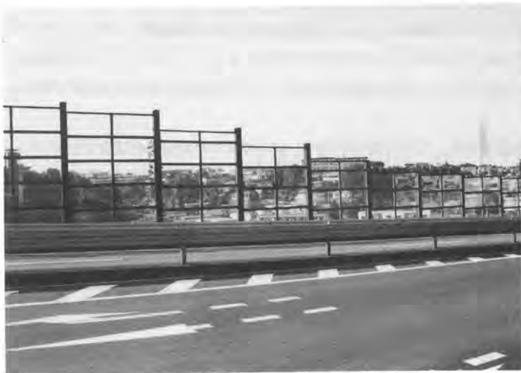
写真-1 透光性遮音壁設置状況
