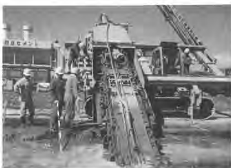
写真-2 鉄筋挿入
