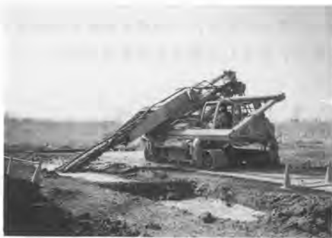
写真-1 施工の状況
