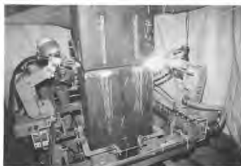
写真-2 柱現場溶接ロボット稼働状況
