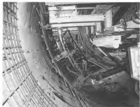
写真-3 鉄筋籠取付け
