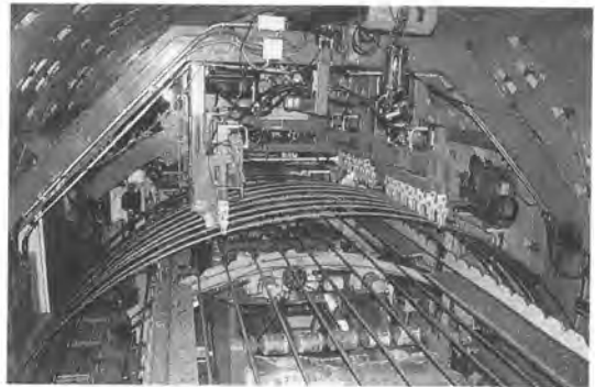
写真-1 主筋配置
