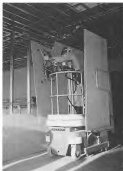
写真8 ボード取付実験 (自走式)
