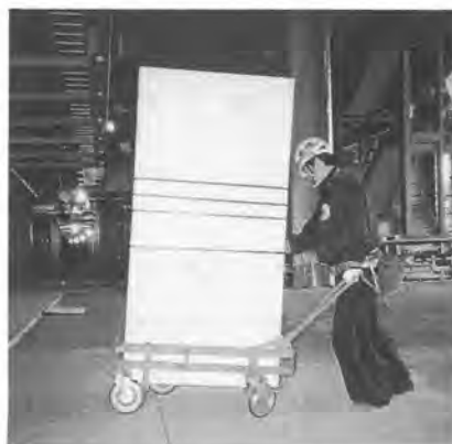
写真3 ボード搬送実験
