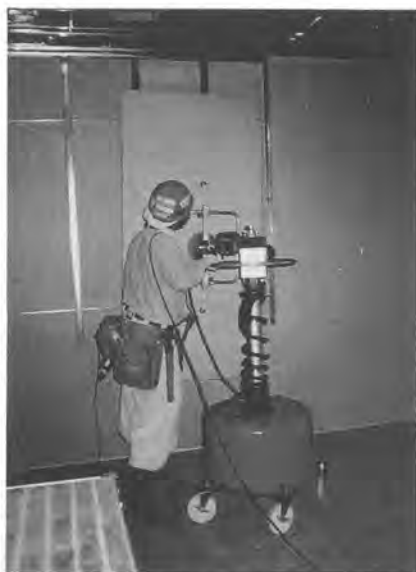
写真7 ボード取付実験 (パーソナル)
