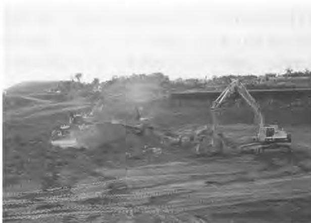
写真-3 遠隔施工状況
